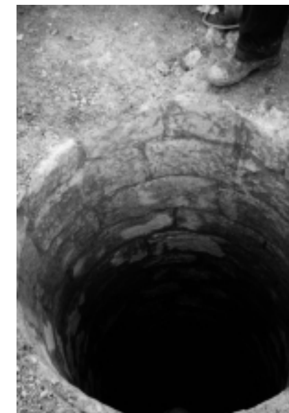
UN MOMENTO DEI LAVORI di ripristino del pozzo (foto gentilmente concessa dal sig. Vinicio Flebus)
